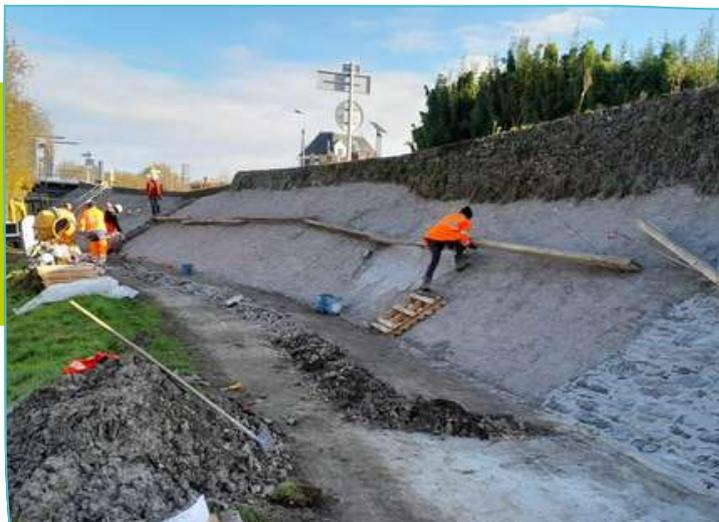
Travaux de rejointement des perrés de la digue à la levée de la Divatte.
